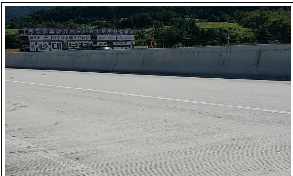
교량 상부 전경
