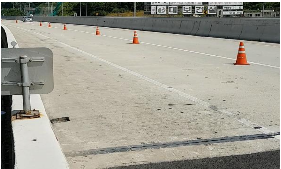
교량 상부 전경
