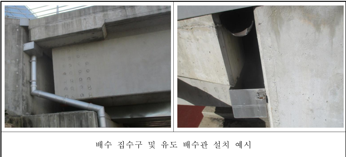
<그림 6.3.14> 신축이음하면 유도 배수관 설치
